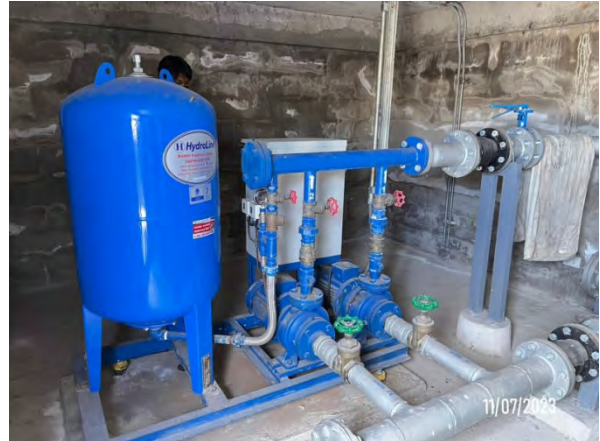
รูปที่ 2-16 Booster Pump
