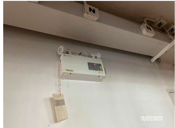
รูปที่ 2-34 ไฟฟ้าส่องสว่างฉุกเฉิน
