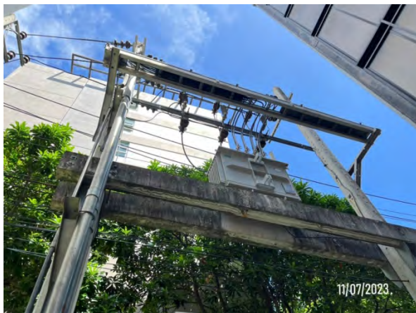
รูปที่ 2-33 หม้อแปลงไฟฟ้าและตู้ควบคุมระบบไฟฟ้า
