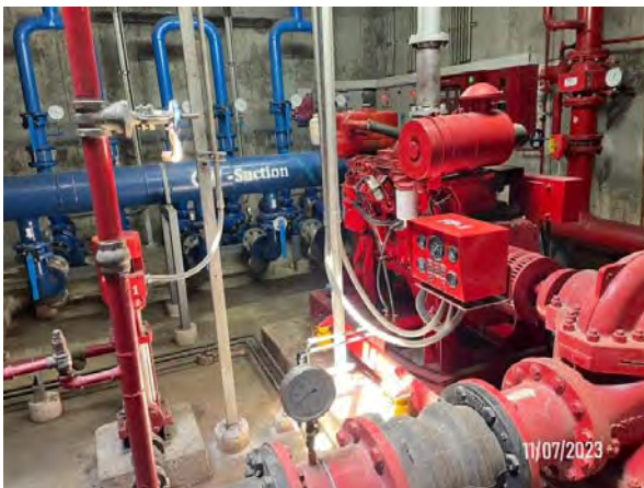
รูปที่ 2-17 ระบบสูบน้ำดับเพลิงและตู้ควบคุมระบบ
