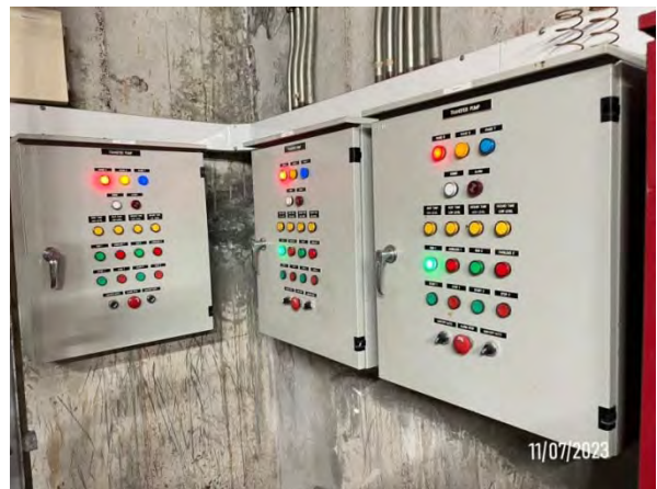
รูปที่ 2-17 ระบบสูบน้ำดับเพลิงและตู้ควบคุมระบบ
