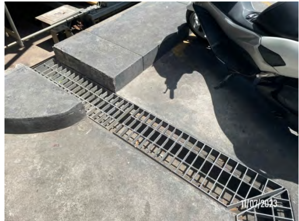
รูปที่ 2-27 บ่อพักน้ำและรางระบายน้ำของโครงการ
